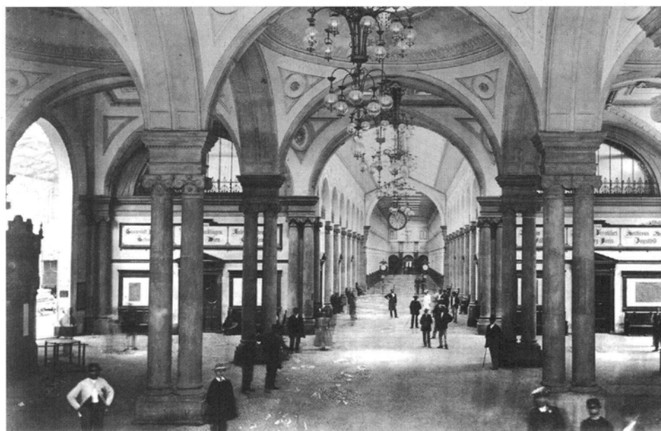
Oben: Der Eingang Schloßstraße des alten Stuttgarter Personenbahnhofs, hier eine Lithographie um 1850 von Leins und Federer, ist heute noch vorhanden und wird als Kinoeingang genutzt. Unten: Die prachtvolle Mittelhalle des alten Stuttgarter Bahnhofs auf einer Fotografie aus dem Jahre 1873. Fotos: Landesbildstelle Württemberg.
